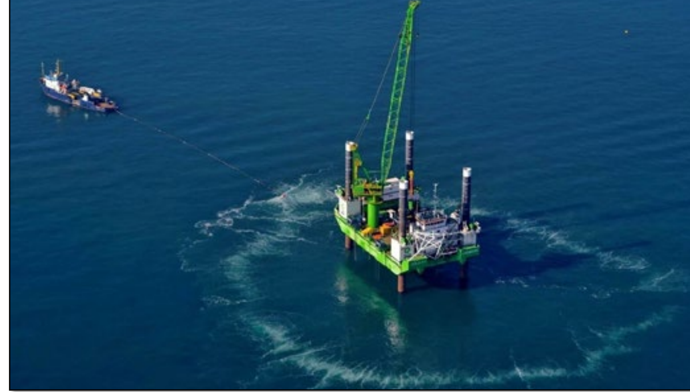
Figuur 9.1: Heien van palen in zee met een 'bellenscherm' wat de verspreiding van onderwatergeluid vermindert OSPAR .
